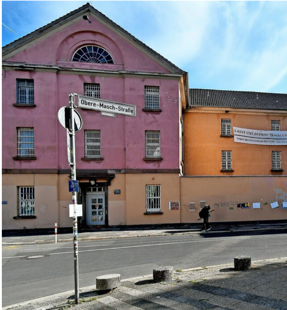
Ehemalige JVA in Göttingen: Die Grünen beantragen eine Machbarkeitsstudie für das Baudenkmal. foto: Christina Hinzmann
